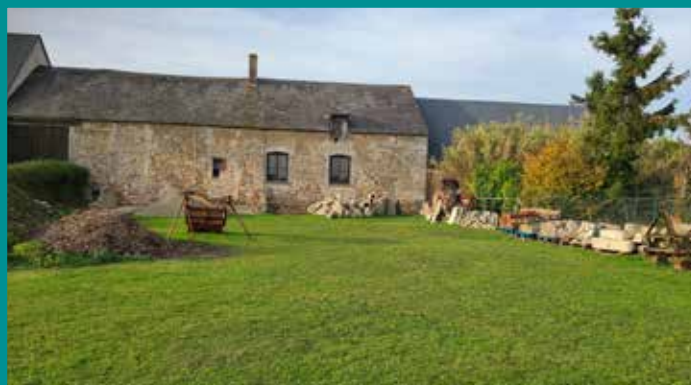
Réfection du mur arrière des locaux des associations
