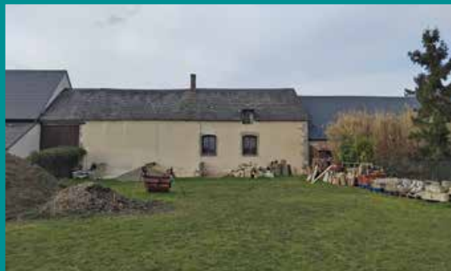
Réfection du mur arrière des locaux des associations
